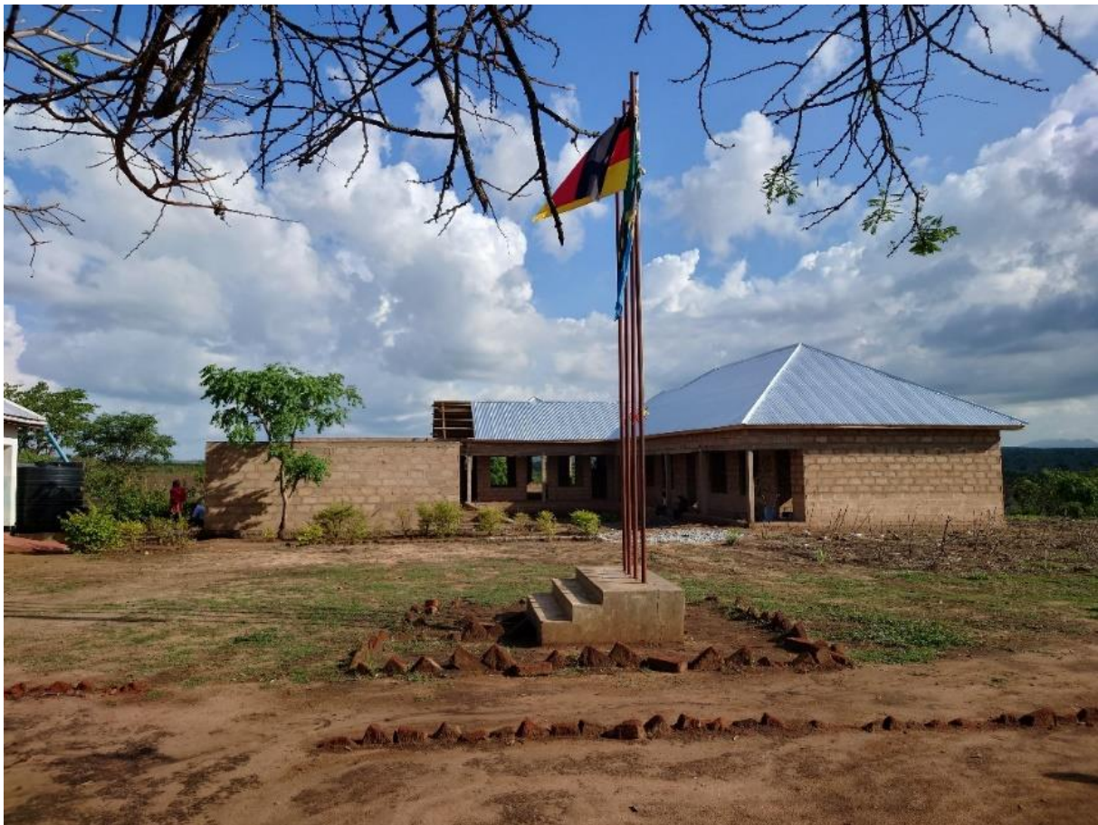
Das Schlafhaus der Schule in Maharaka Village mit Dach
